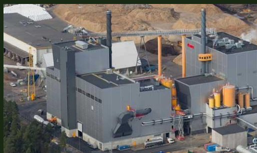
Eon Händelöverket 75 MW CFB
